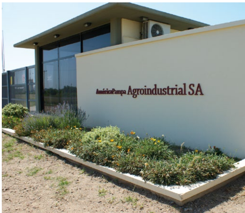
Entrada a la planta.
