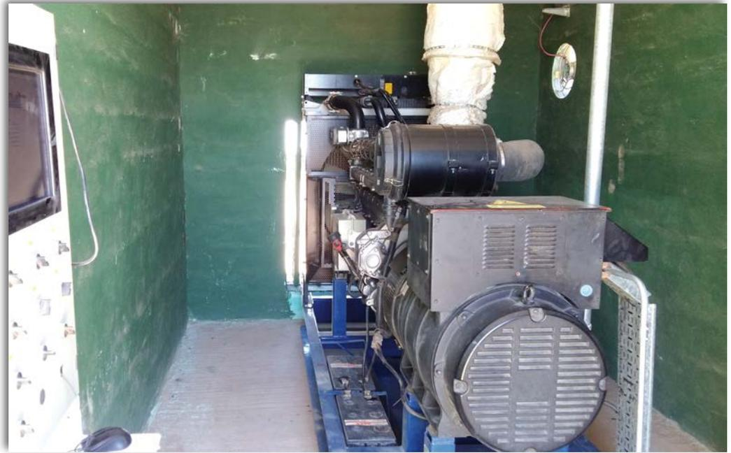
Motor-generator Scania de seis cilindros. Posee capacidad para generar 220 kilovatios por hora.
